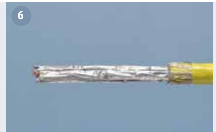
6 Bündelverseilung aufdrehen. Untwist the pairs.
